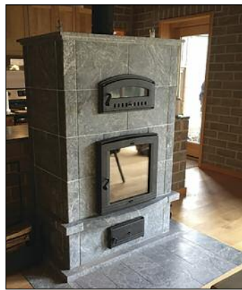
Fireplace masonry heater / foyer en pierre stéatite radiateur en maçonnerie
