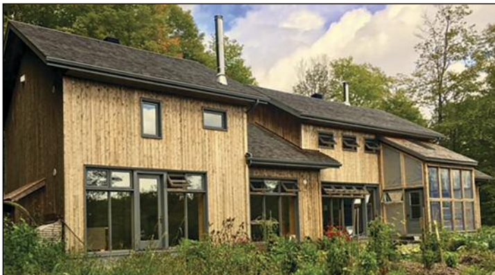
Mud brick house / une maison en briques crues Photo: Ginette Dupuy
